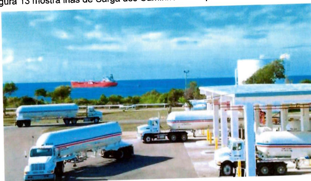
Figura 13 — Ilhas de Carga dos Caminhões-tanque Fonte: Central propagas
