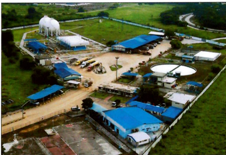
Figura 8 — Planta de GLP.
